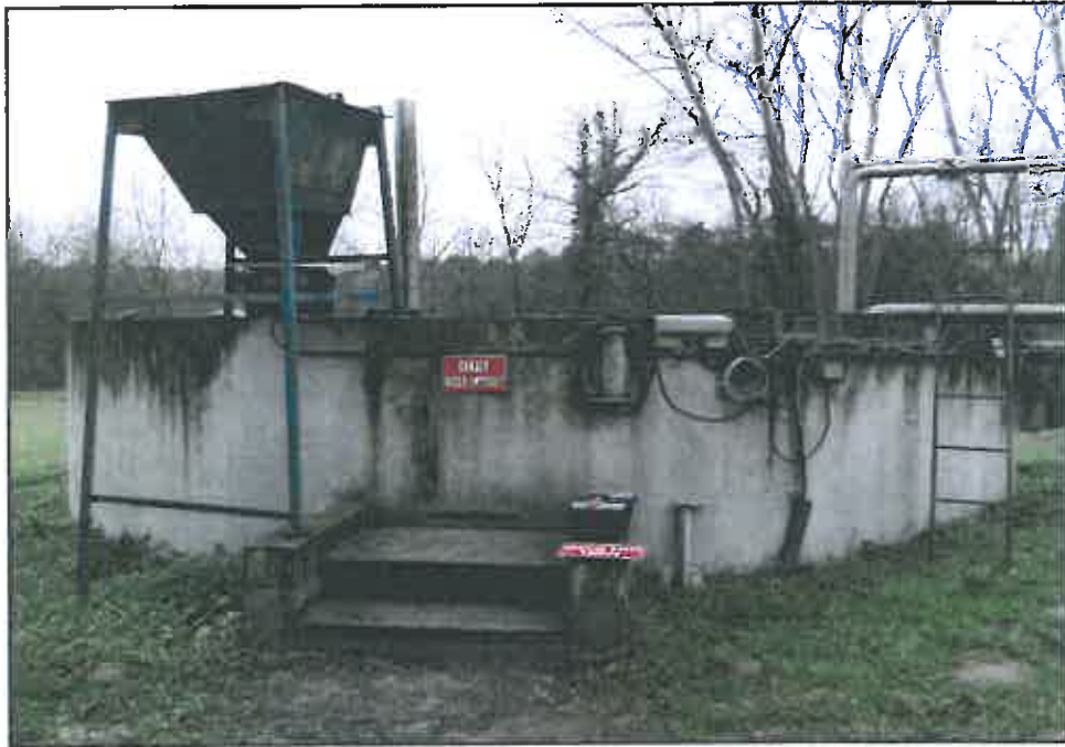
Figure 3 : Pose de la signalétique sur la STEP
