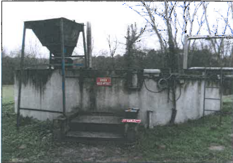
Figure 3 : Pose de la signalétique sur la STEP
